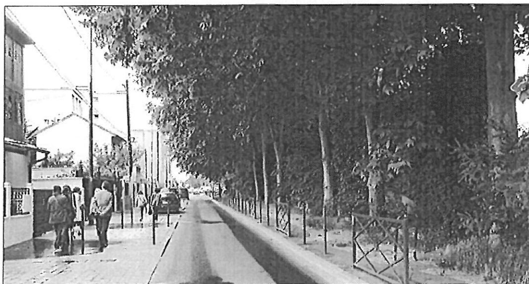
Bâti avenue de Stalingrad, mur anti-bruit végétalisé rue du Président Salvador Allende, exemples d'espaces impactés par le projet – Source : DRIEE Île-de-France 2014
